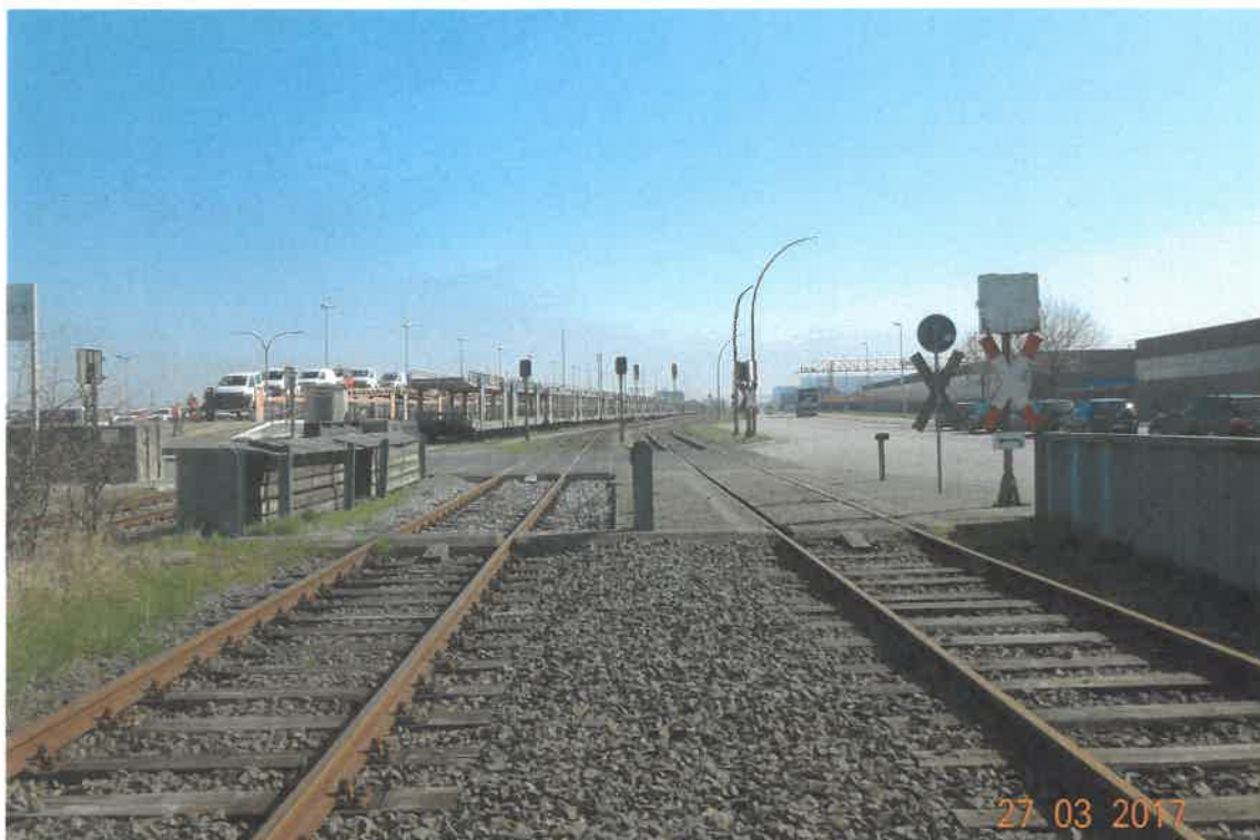
BÜ Marine Blickrichtung Osten (Ausfahrt)
