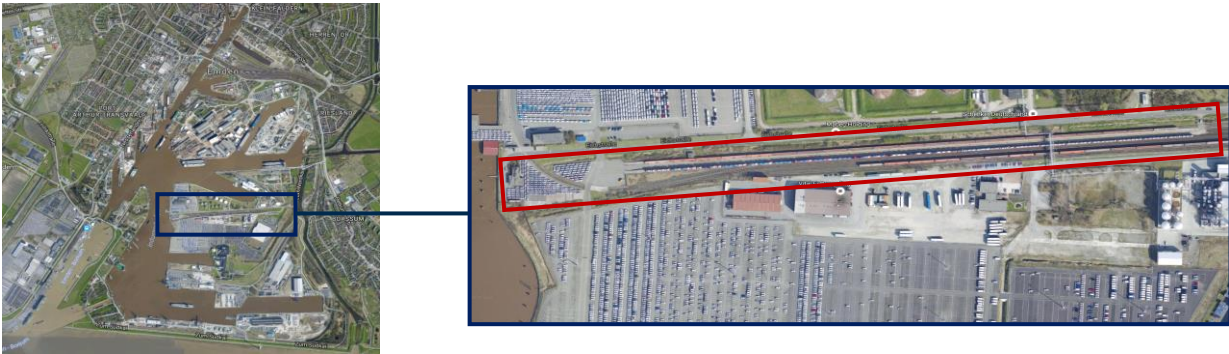
Abbildung 1: Lage der Gleisfeldanlage im Emdener Hafen
