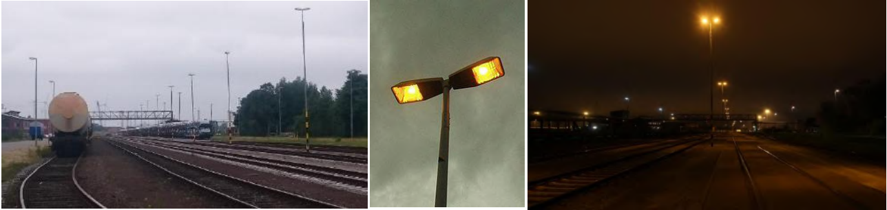
Abbildung 3: Die Ausgangslage auf dem Gleisfeld
