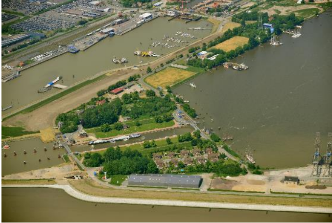
Betrieb der Schleusen
